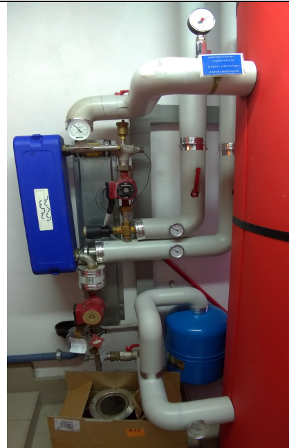
Fig. 4 - scambiatore di calore esterno al boiler
