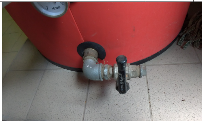
Fig. 5 - particolare scarico di fondo boiler
