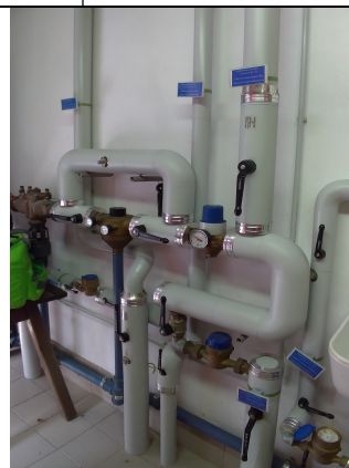
Fig. 6 - condotte a vista isolate impianto acqua calda sanitaria
