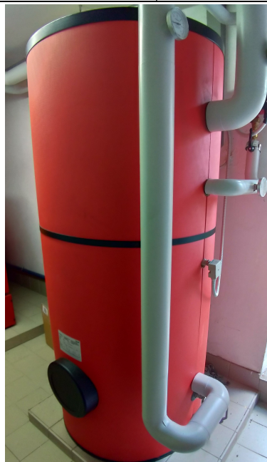
Fig. 3 - boiler da 500 L accumulo acqua calda sanitaria
