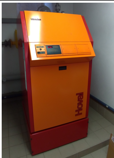
Fig. 2 - unità termica a metano
